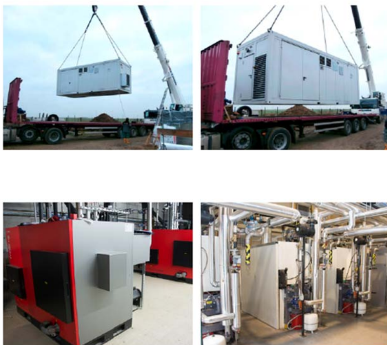
Slika 6: Primer zunanje in notranje vgradnje SPTE naprave
